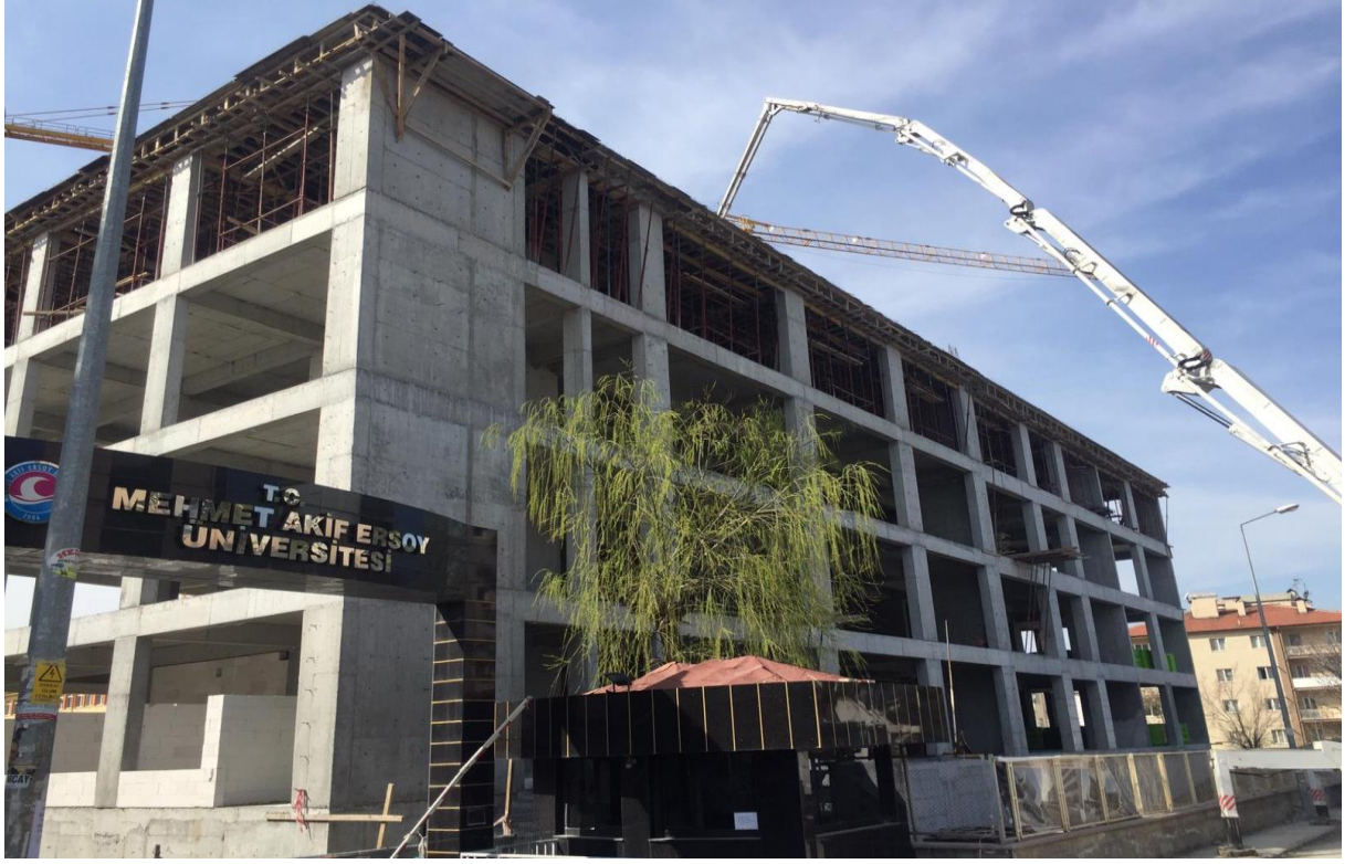
Diş Hekimliği Fakültesi İnşaatı
