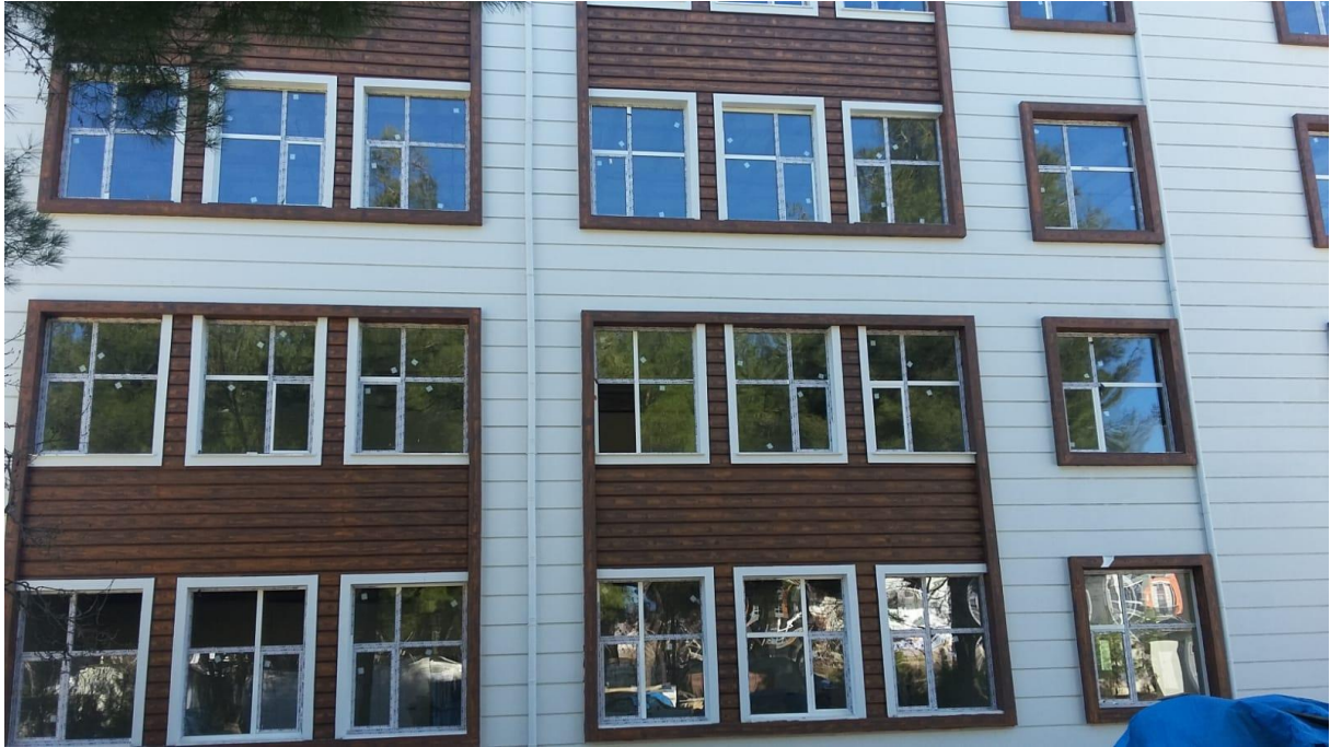
Bucak Sağlık Yüksekokulu İnşaatı
