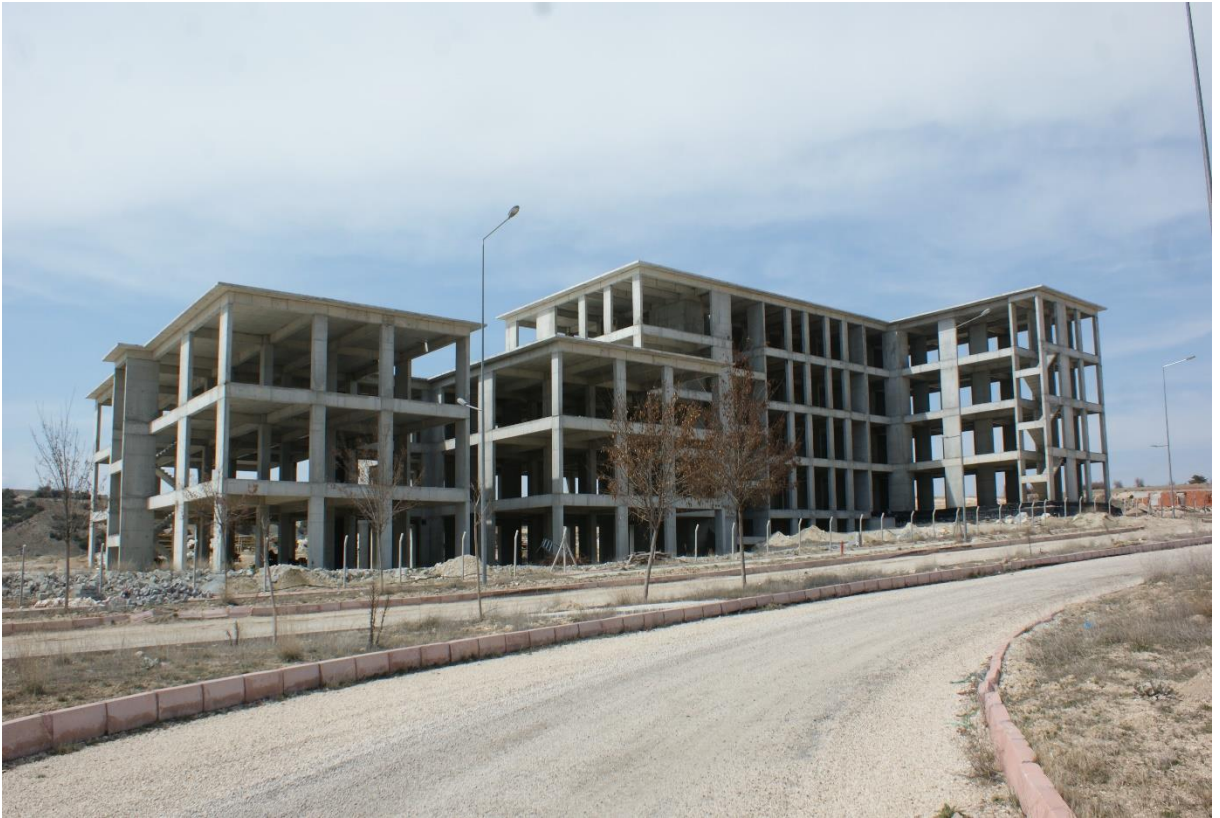
Mühendislik Mimarlık Fakültesi İnşaatı
