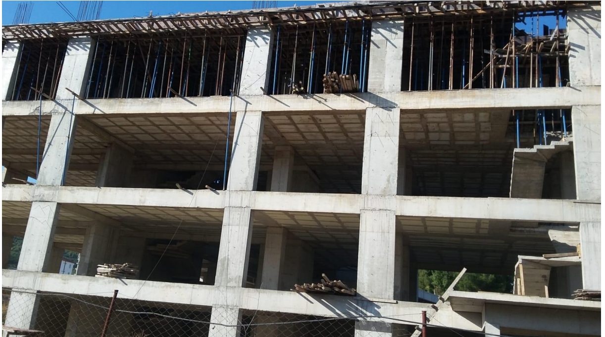
Bucak Sağlık Yüksekokulu İnşaatı
