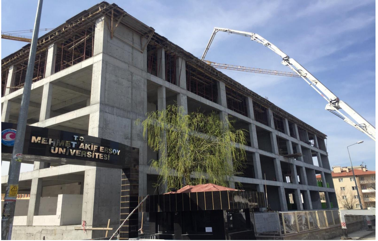
Diş Hekimliği Fakültesi İnşaatı
