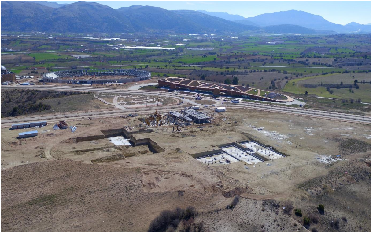
Mühendislik Mimarlık Fakültesi İnşaatı
