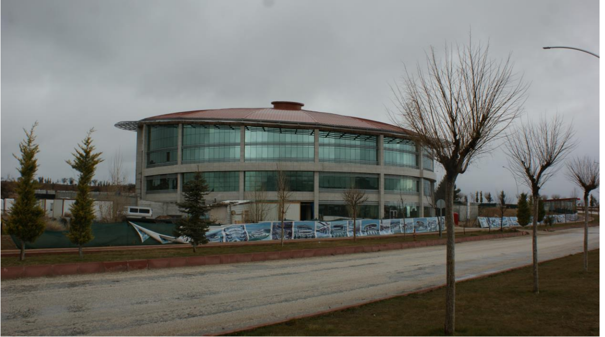
Kütüphane Binası İnşaata
