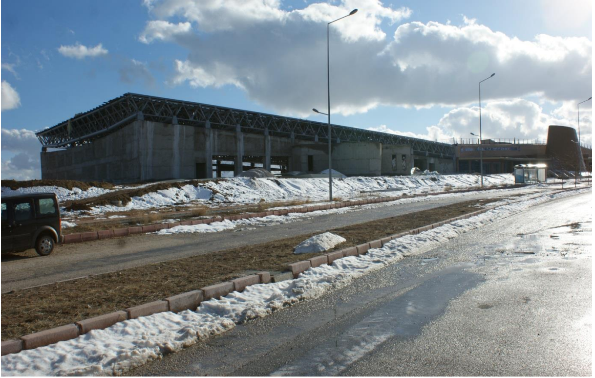
Spor Kompleksi C Blok İnşaatı
