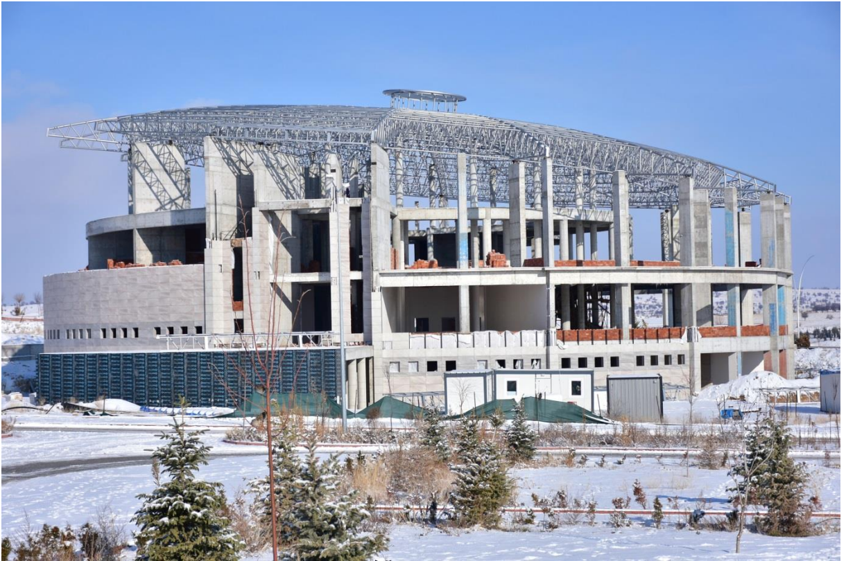
Kütüphane Binası İnşaatı
