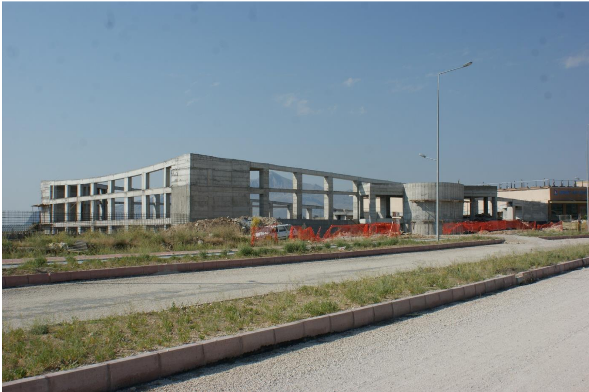
Spor Kompleksi C Blok inşaatı
