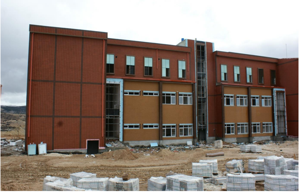
Eğitim Fakültesi Dekanlık Binası İnşaatı
